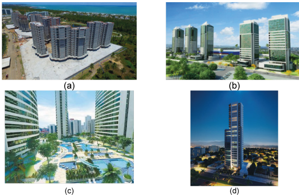
Figura 6 – Aplicações a alvenaria de vedação de grandes edifícios
